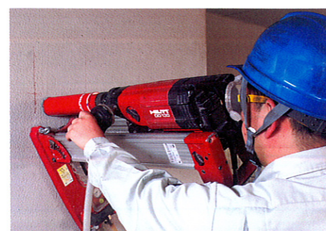
使用例3：穿孔前の鉄筋確認に (クイックスキャンによる鉄筋位置とかぶり厚の確認)
